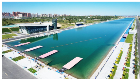
金麻片区疏干水蓄水池
