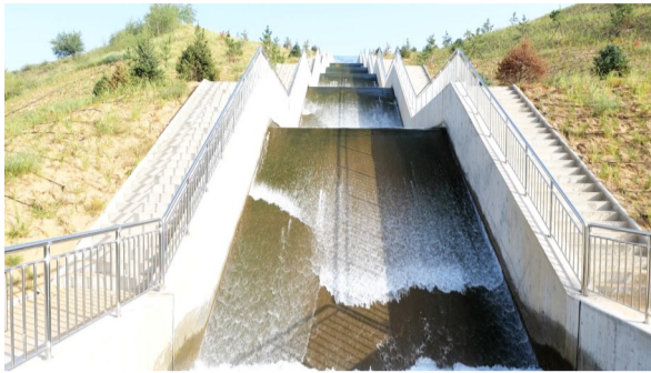
西沟河多级跌水工程
