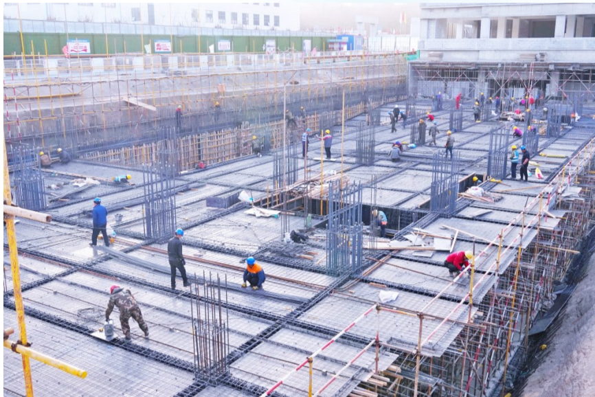
姜谭经开区西部智造创新园项目施工现场
