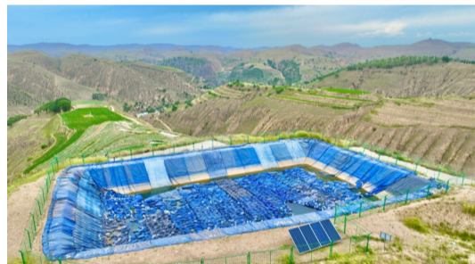
提水补灌工程的蓄水池。
