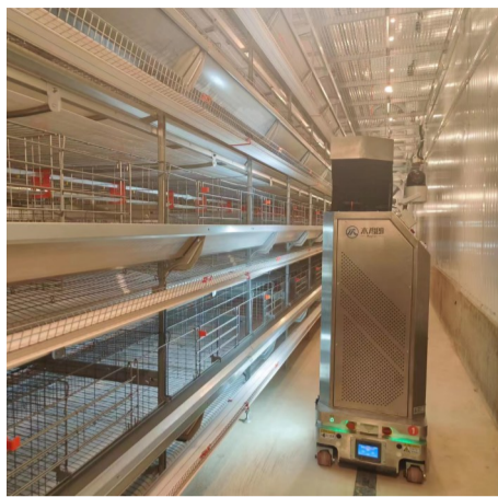
智能巡检机器人。
