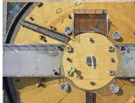
江苏省宿迁市宿豫区粮食产业园集粮食仓储物流、加工贸易、检验检测等为一体,规划建设17栋低温平房仓、10栋低温浅圆仓、粮食加工厂房和烘干中心。全部建成后,仓容量可达20万余吨。以上图为该粮食产业园建设工地。
