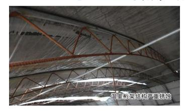
1. 结构局部或整体倒塌, 失去生产功能。如温室立柱局 部断裂或弯曲、屋面梁或拱架 局部构件断裂、结构件与基础 连接处锈蚀影响结构安全。
