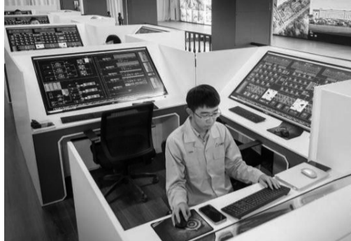
工作人员在中控室对各楼层的温度、湿度、饲料喂水等环节进行智能化的精准控制。
